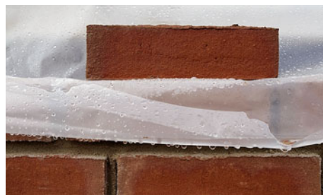
Klinkersteine auf einer Baustelle
